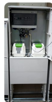
Energoozczędne dmuchawy JDK-S z zabezpieczeniem przebicia membran
