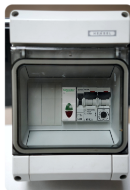
Skrzynka zabezpieczająca (z wyłącznikiem silnikowym pompy) w obudowie 6 modułowej o stopniu ochrony IP 65.
