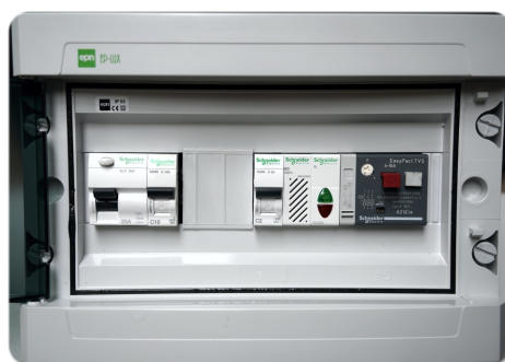
Skrzynka zabezpieczająco-alarmowa (z zabezpieczeniem przeciwporażeniowym w postaci wyłącznika różnicowoprądowego oraz wyłącznikiem silnikowym pompy). Dodatkowo wyposażona w alarm świetlny i dźwiękowy. Obudowa 12 modułowa o stopniu ochrony IP 65.
